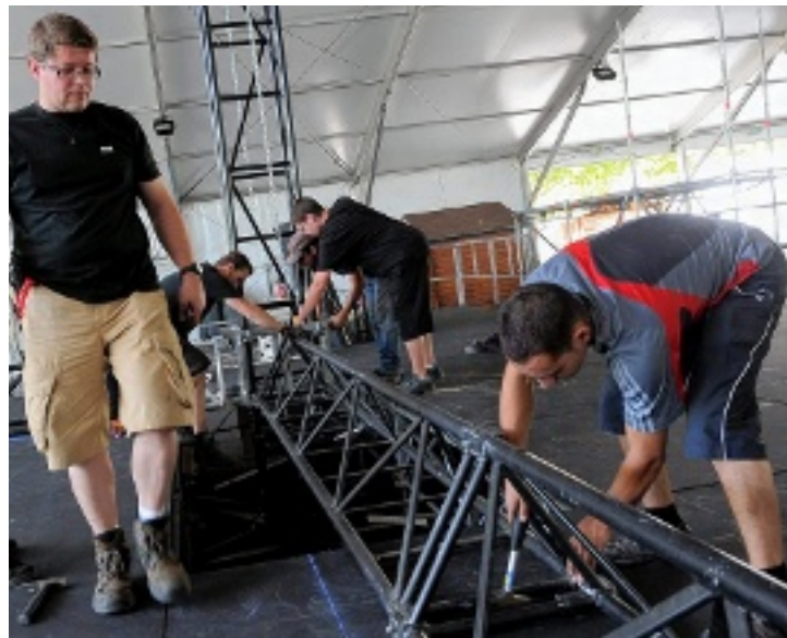
Place Voltaire, le grill technique est en plein assemblage. Il reste encore beaucoup à faire avant le premier concert, mardi soir.
